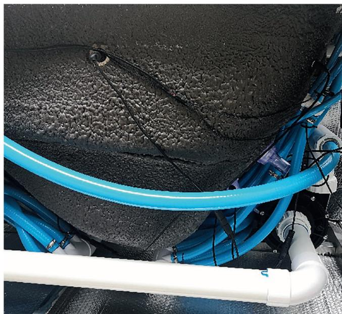
Une cuve avec projection de mousse polyuréthane.
